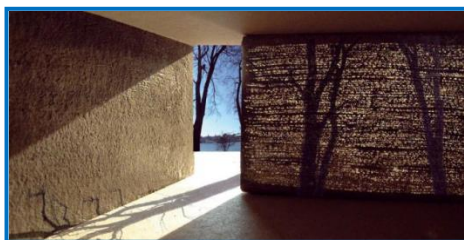
Rys.3. Przykład zastosowania ściany z betonu przezroczystego.
